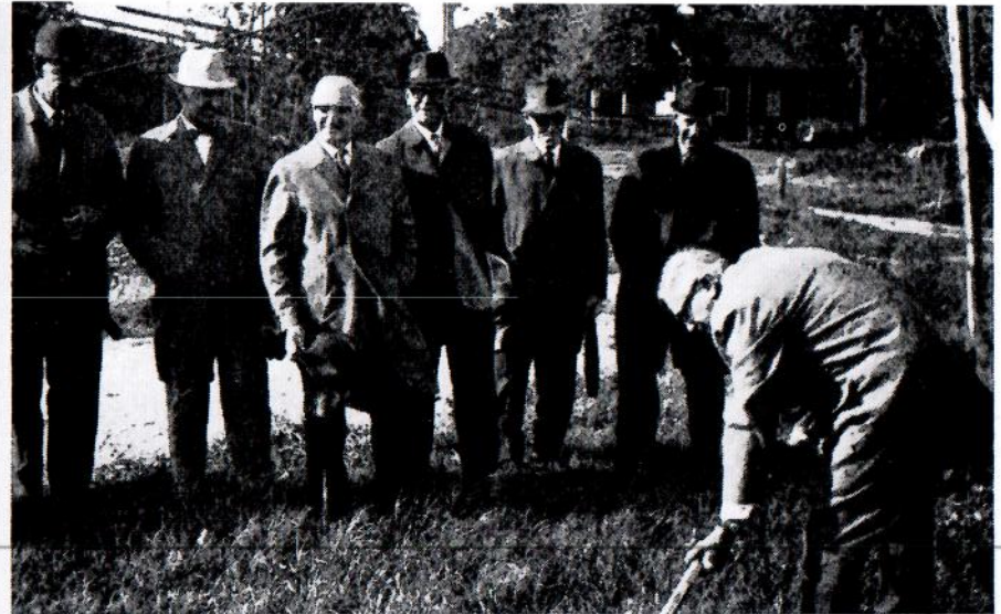
Tillsammans med representanter för kommun och länsförbund tog ordföranden Åke Hansson det första spadtaget till den nya tappstationen.
